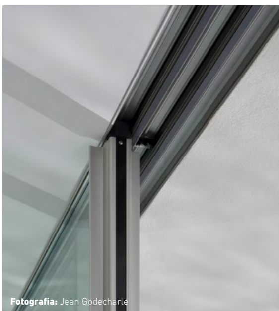
Vista dell'anta aperta con telaio superiore incassato nel soffitto.
