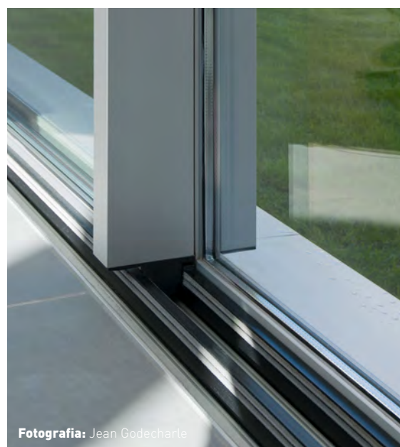
Dettaglio dell'incontro centrale delle due ante con telaio inferiore complanare internamente ed esternamente.
